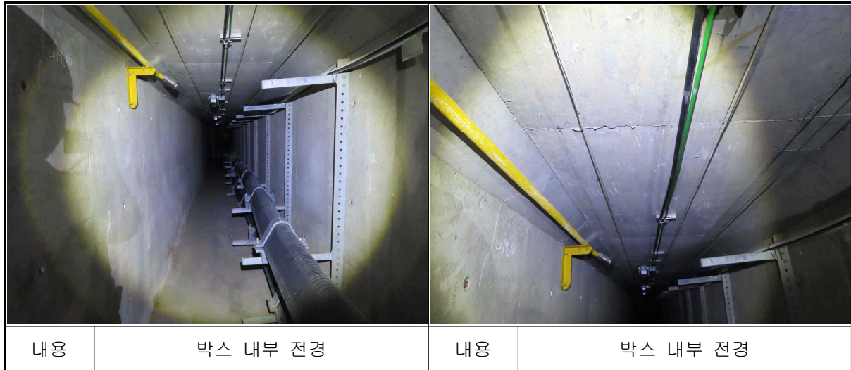
【사진 15.1】 송포일산인출 전력구 현황
